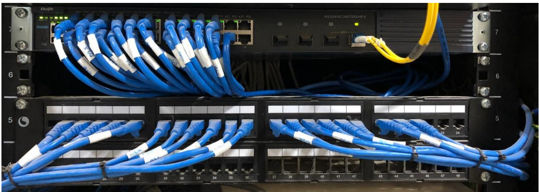
ภาพที่ 3.3 แสดงจำนวนช่องเสียบของอุปกรณ์สลับสัญญาณ (Switching) ที่ไม่เพียงพอ
