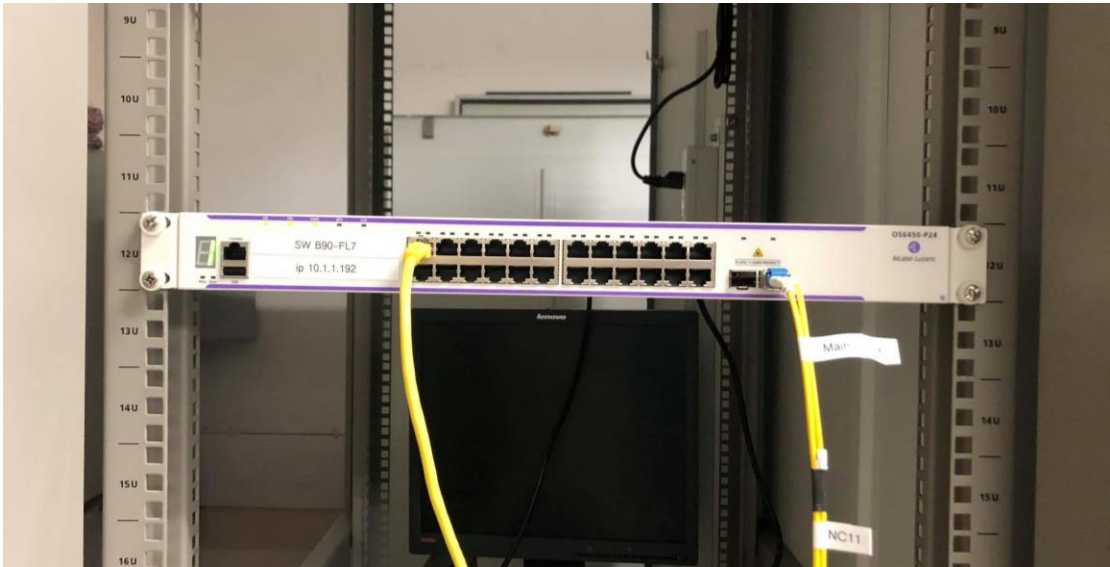
ภาพที่ 4.80 แสดงลักษณะของการใส่ Lable
