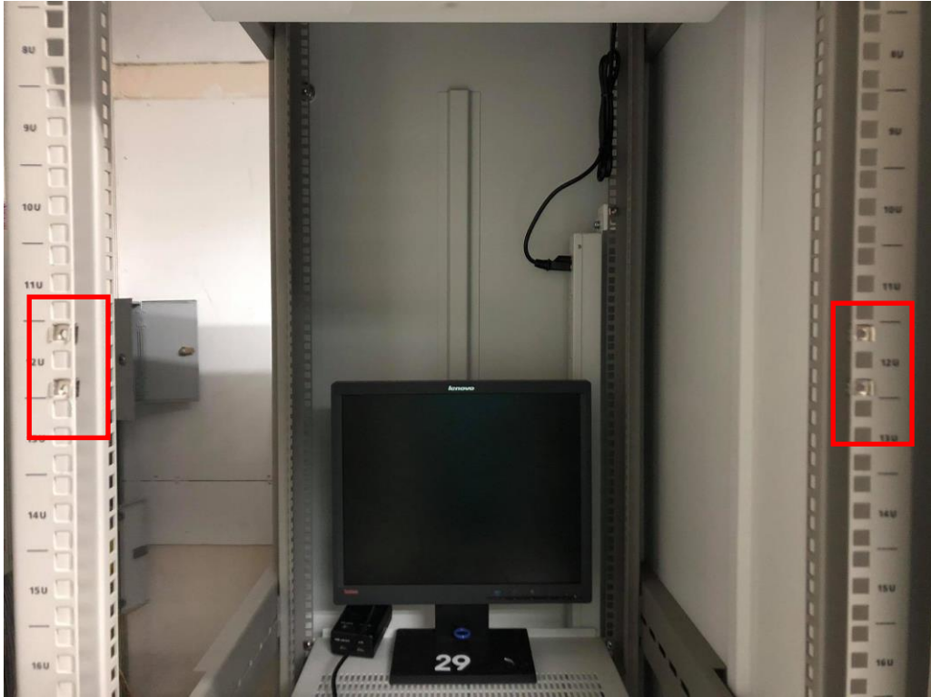
ภาพที่ 4.62 แสดงการยึดน็อต (CAGE NUT)
