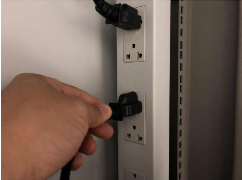
ภาพที่ 4.68 แสดงการเสียบสาย AC Power
