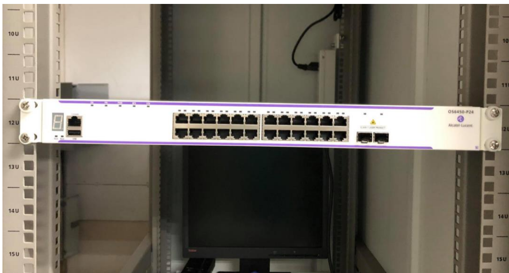
ภาพที่ 4.67 แสดงเมื่อยึดน็อตเสร็จเรียบร้อยแล้วทั้งสองด้าน
