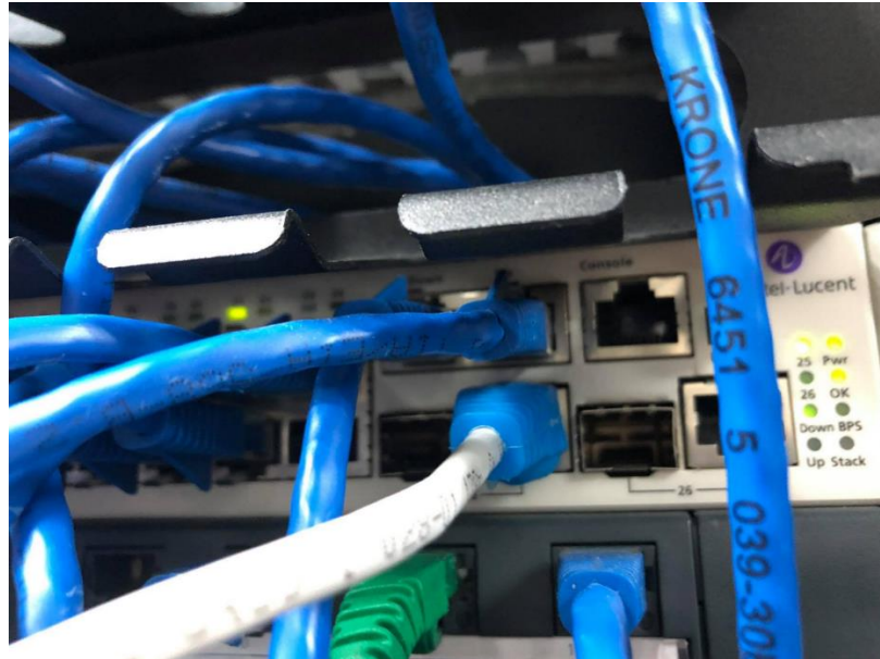
ภาพที่ 4.88 แสดงการตรวจสอบสาย Uplink กรณีที่เป็นสาย LAN
