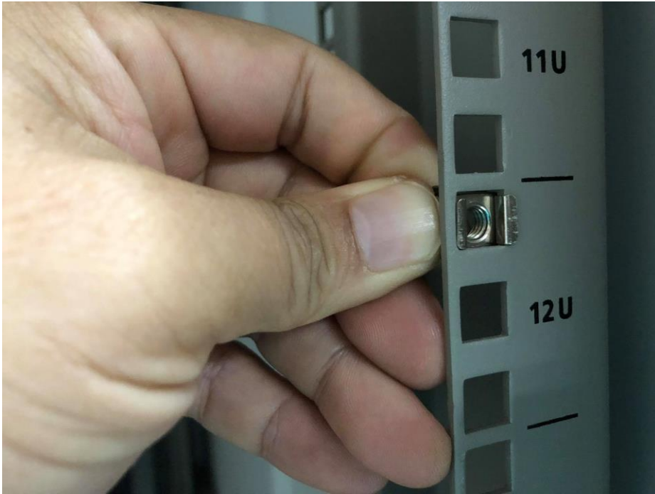
ภาพที่ 4.60 แสดงการนำน็อตสำหรับยึด Rack ตัวเมีย (CAGE NUT)
