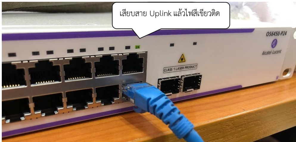
ภาพที่ 4.32 การเสียบสาย Uplink เข้ากับระบบ
