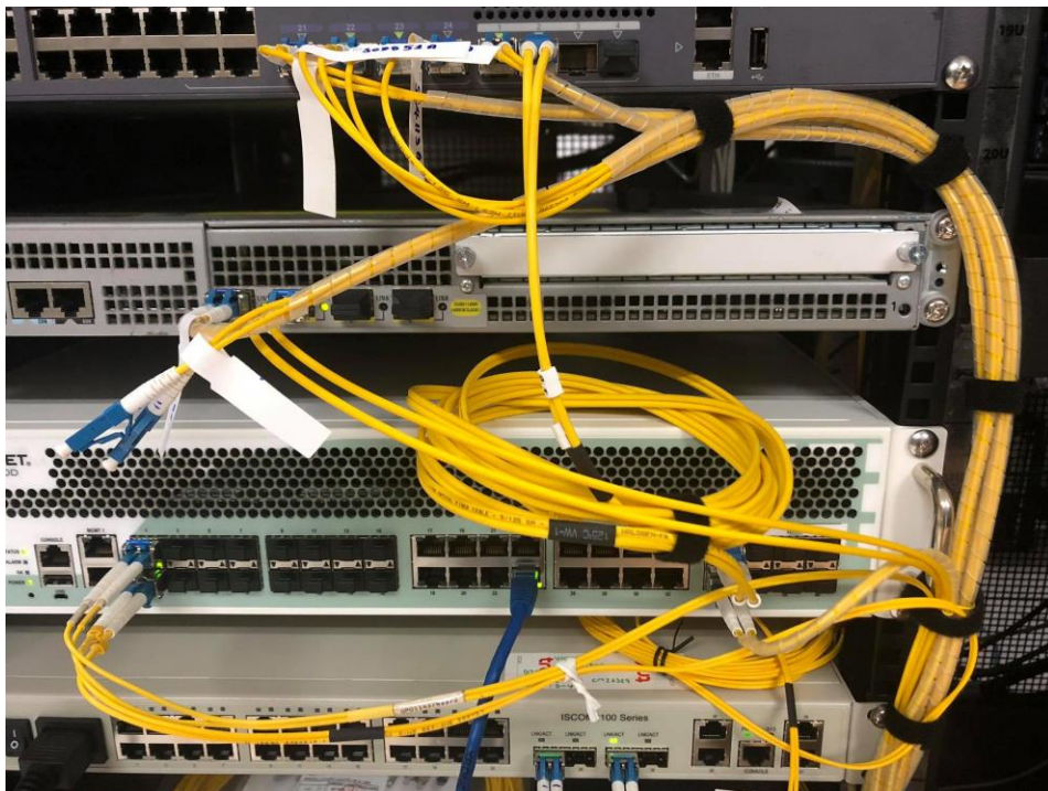
ภาพที่ 3.8 แสดงการเก็บ Patch Fiber Optic ที่มีความเรียบร้อย
